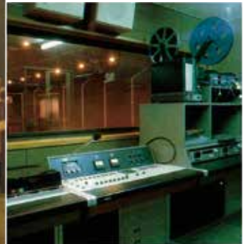
小ホール 映写室
