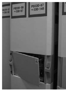
▲23号館 電動書架の破損
