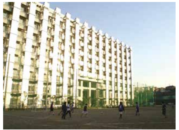
免震構造の23号館(工学部棟)
