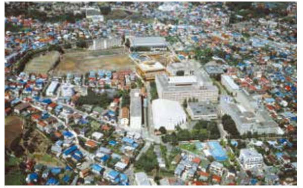
17号館の建設が始まったころのキャンパス(1981年)
