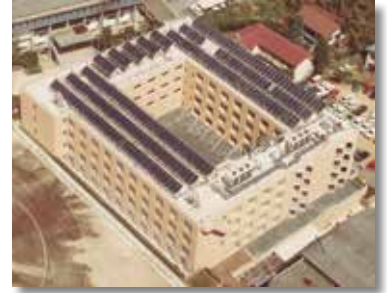
ソーラーシステムを導入し、室内プールを備えた17号館研究棟
