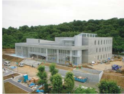
完成目前の様子。7月1日撮影
