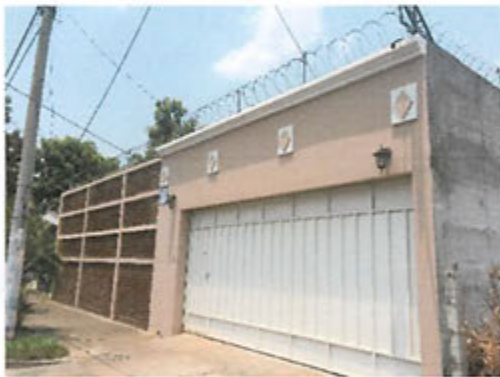
4 mの塀の上には針金のコイル
