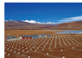
チベット宇宙線空気シャワー観測装置。シンチレーション検出器を約3.7ヘクタールの広さに約800台配置。
