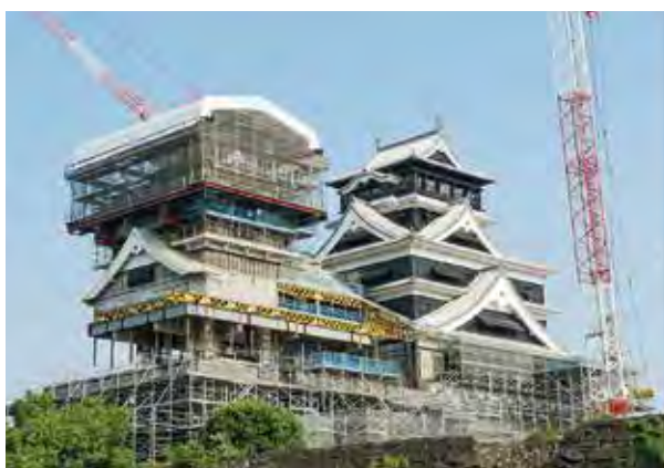
復旧中の熊本城
