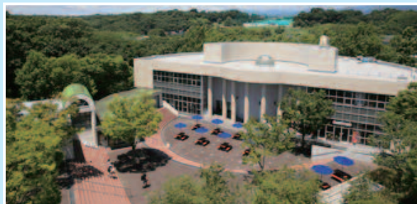
H 4号館(厚生棟)
