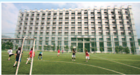
Y 総合グラウンドと23号館
