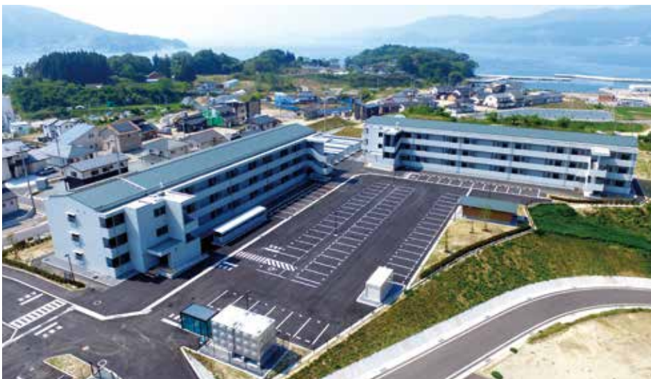
弊社が手掛けた、岩手県陸前高田市脇の沢地区の災害公営住宅新築工事
