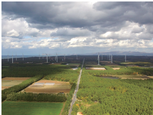
ウインドファームつがる（青森県つがる市）に据え付けの完了した巨大風車＝高さ100m×羽50m、30階建てビルに相当
