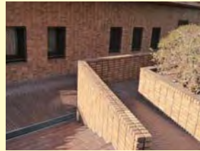
図書館外側のスロープ
