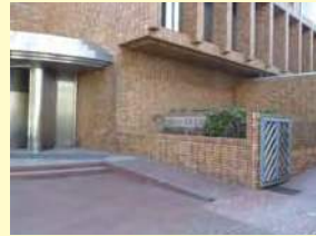
図書館入口スロープ
