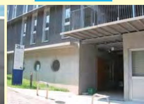
エレベーターで2階へ
